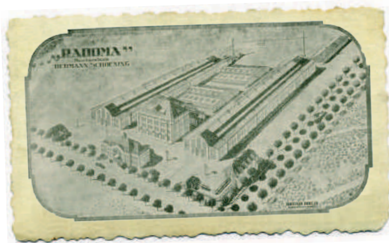
Die Maschinenfabrik Hermann Schoening wurde 1915 in Borsigwalde eröffnet, Herzstück war die Fabrikationshalle von Bruno Buch
