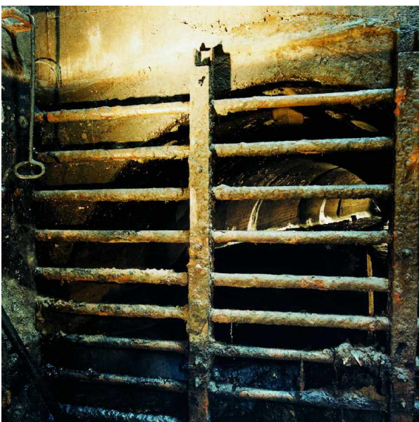
Sperrgitter im Kanal Stubenrauchstraße, 1999 Foto: Rene Quabbe, © Museum im Wasserwerk
